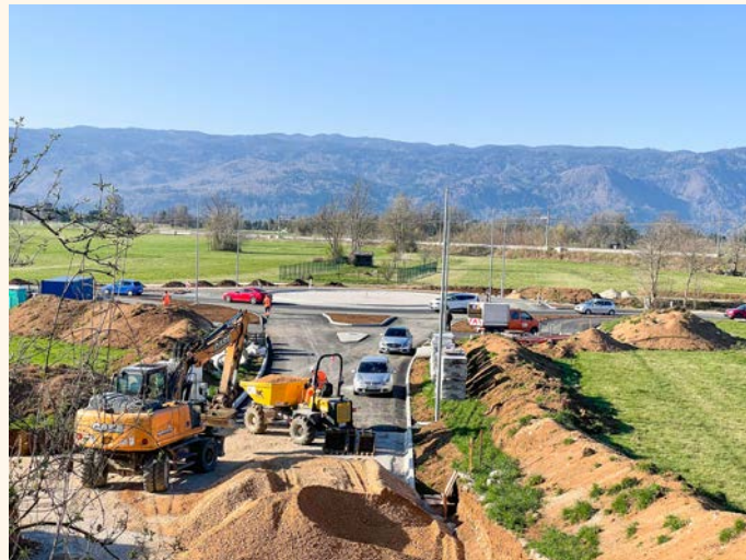
Gradnja križišča za priklop obvoznice na cesto Radovljica–Jesenice
