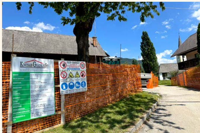
Gradbišče v Vrbi bo po načrtih odprto osem mesecev.
