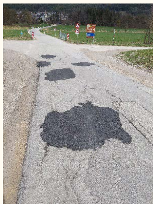
Obnova asfalta na cesti Rodine-Hraše
