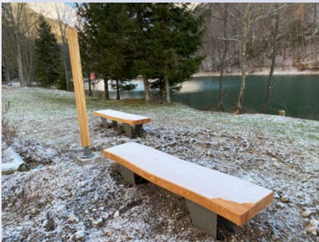
Ob jezeru v Završnici poteka nameščanje urbane opreme.
