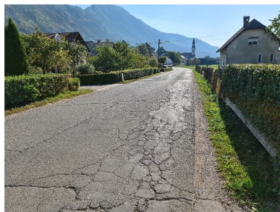
Utrujen asfalt na glavni prometni površini skozi Breznico
