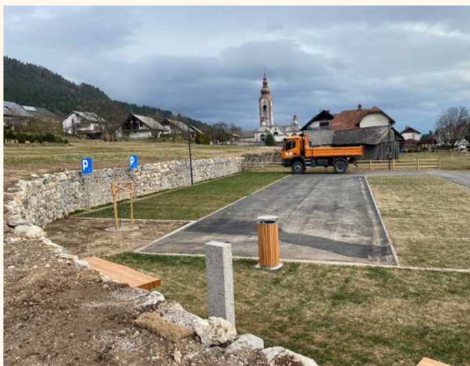
Zatravljena parkirna mesta in suhozložni zid na Rodinah
