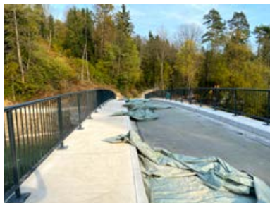
Na mostu in brežinah potekajo zaključna dela.
