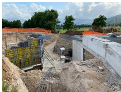
Gradnja podvoza na Selu
