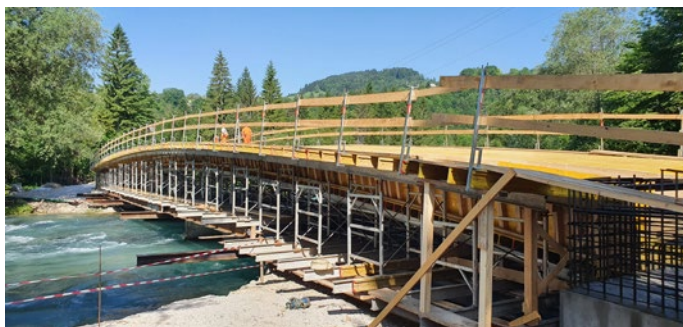
Podporna konstrukcija mostu
