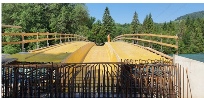
Opažna konstrukcija mostu
