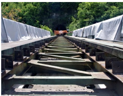
Obnova železniškega mostu.
