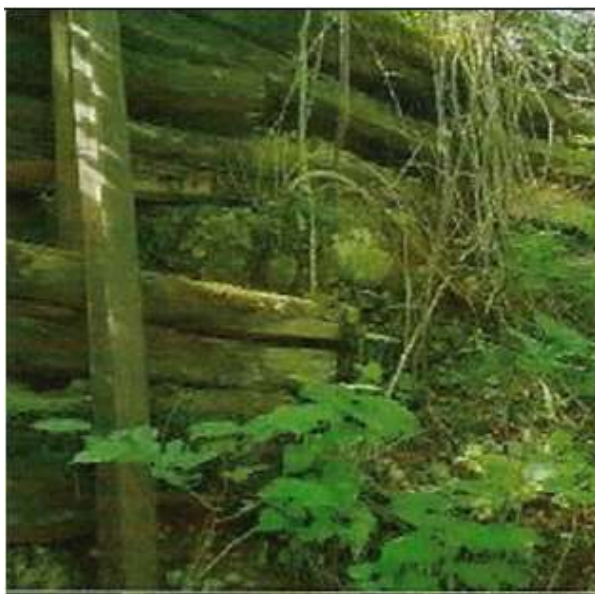
OPORNI ZID NAD CESTO PROTI MATUHOVEMU MOSTU
