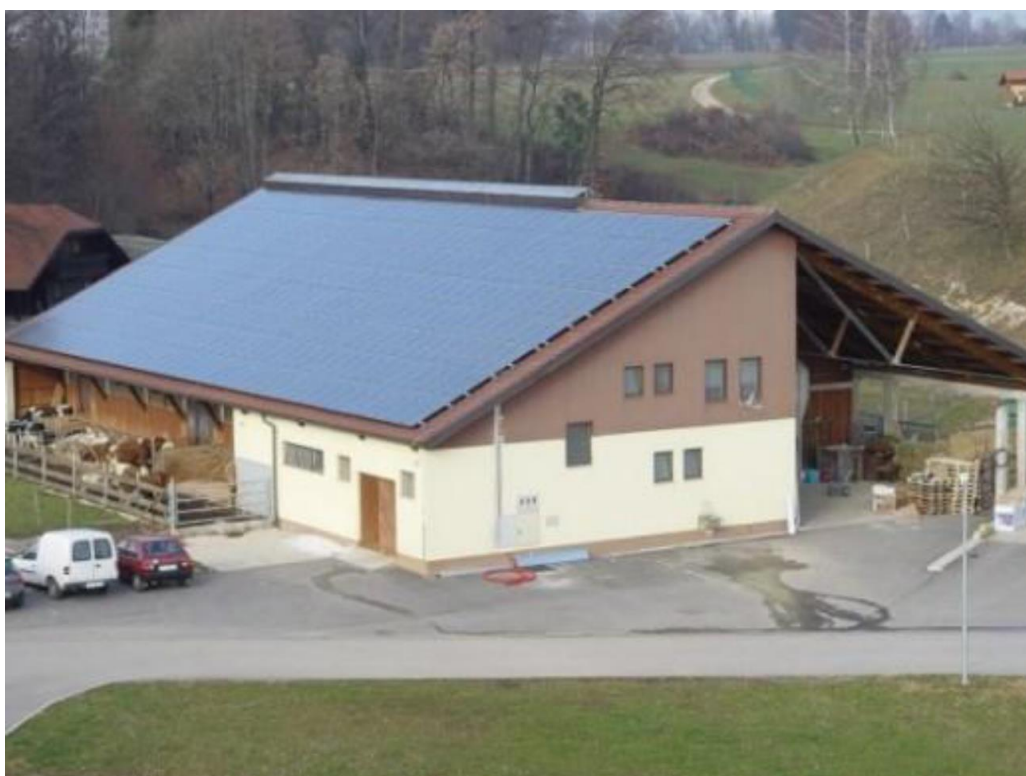
Slika 9-11: Sončna elektrarna na strehi objekta
