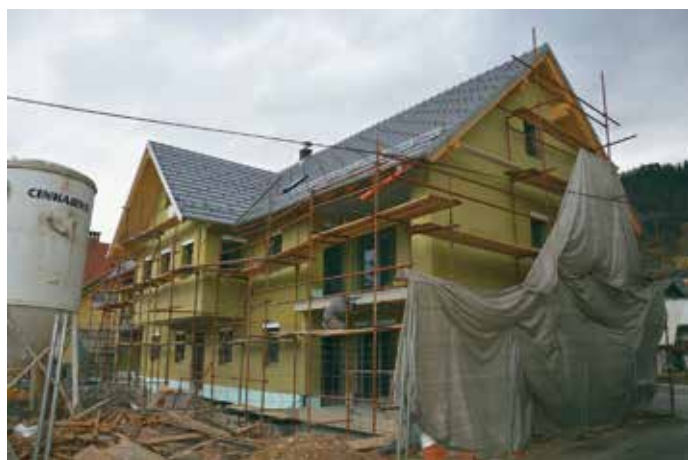
Gradnja stanovanj na Selu bo predvidoma končana konec letošnjega avgusta.
