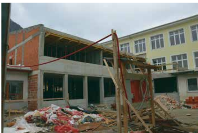
Investicija pri šoli obsega gradnjo jedilnice, učilnic, igralnic in sanitarnega bloka.
