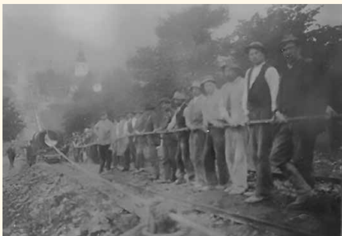
Gradnja cevovoda nad Mostami
