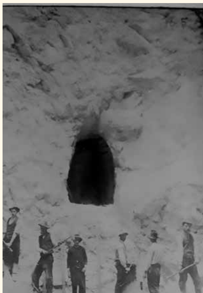
Dovodni rov v vodostan je prebit.
