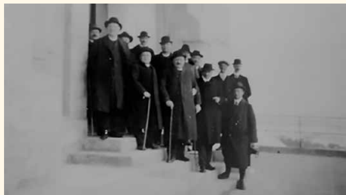
Deželni veljaki so si prišli ogledati gradnjo vodostana nad Žirovnico.
