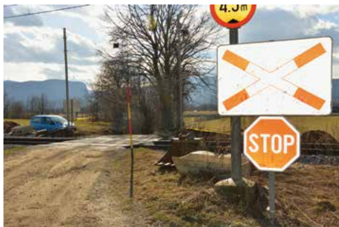
Ureditev železniškega prehoda na Selu je v pristojnosti Slovenskih železnic, ki do danes, kljub večkratnemu posredovanju Občine Žirovnica, niso storile ničesar.
