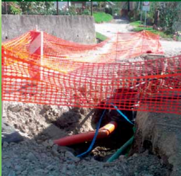
Gradnja kanalizacije v naselju Žirovnica
