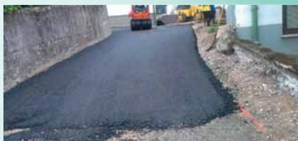
Asfaltiranje ulic v naselju Selo pri Žirovnici
