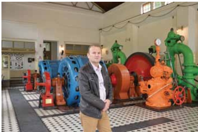
Anton Koselj pred lepo ohranjenimi agregati prve Kranjske deželne elektrarne
