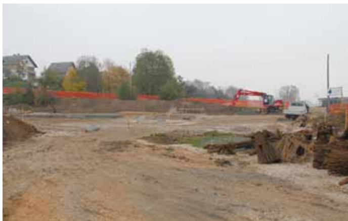
Pričetek gradnje zbirnega centra na obrobju poslovne cone
