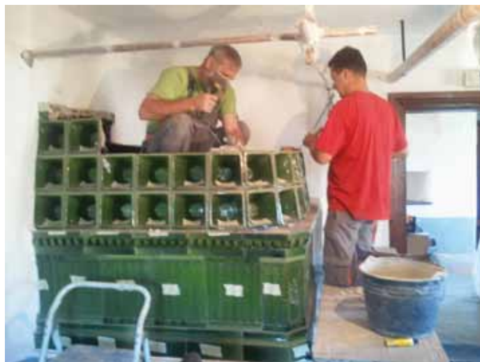
Sanacija peči je bila zaradi uhajanja plina nujno potrebna.
