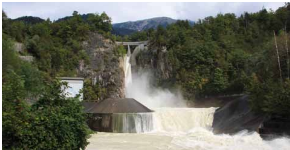
Pogled s poti na pregrado HE Moste.
