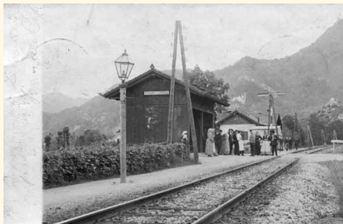
Prvo železniško postajališče v Žirovnici s čuvajnico.
