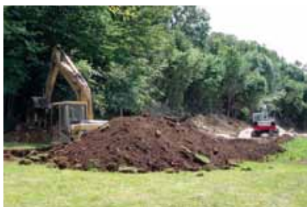
Gradnja povezovalnega kanala v Vrbi.
