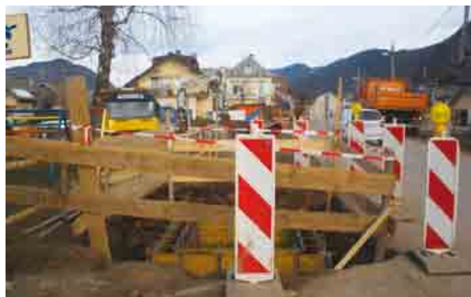
Gradnja pločnika na Selu
