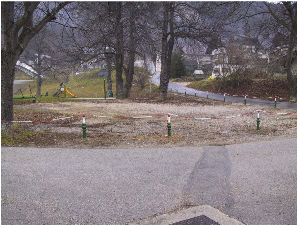
Ograditev novega otroškega igrišča v Glenci z stebrički in verižico
