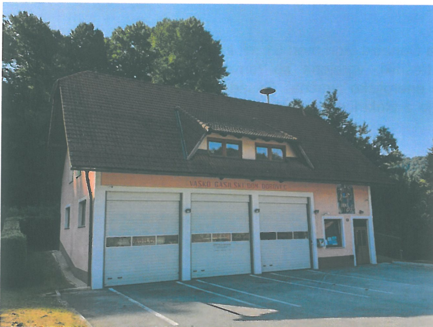
Slika 6.14: Vaško gasilski dom Dobovec.
