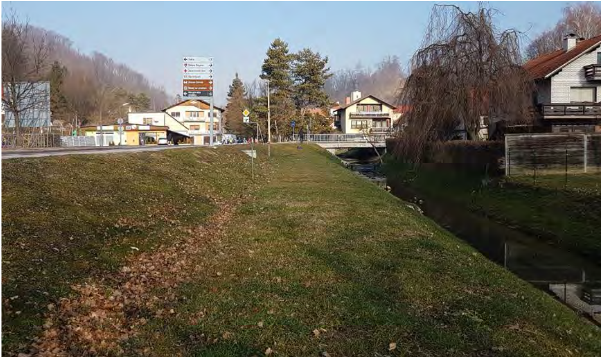
Slika 1: Pogled od samega začetka proti bodočemu rondoju, ki je predviden levo od sedanjega mostu čez reko Draganjo. V tem delu je potok že urejen, prisotna je tudi že manjša poplavna terasa za potok, ki je podobno zamišljena tudi za obravnavani projekt. Bodoča trasa ceste se bo na rondo priključila levo od potoka.
