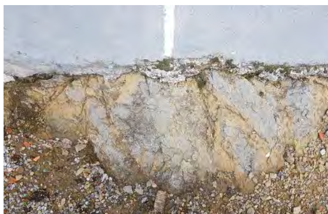
Sliki 7 in 8: Peščenjaki v katerih je temeljen dvorec Strmol in njihovo značilno preperevanje
