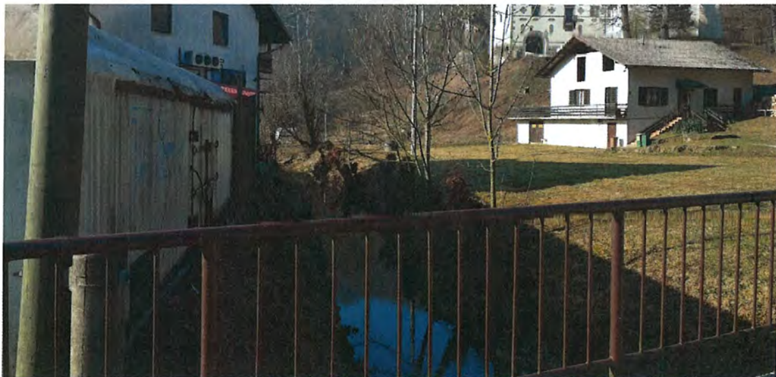
Slika 6: Blizina struge in objekta pred obstojecim mostom
