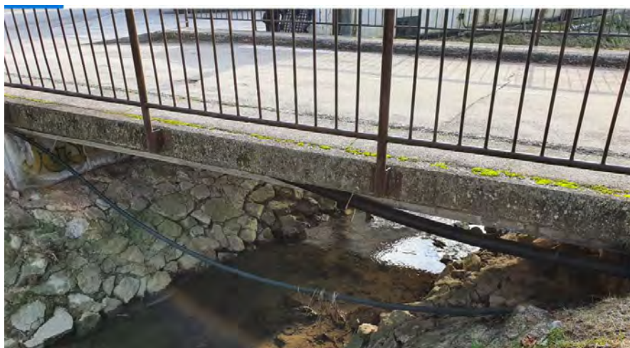
Slika 7: most na Poti k ribniku
