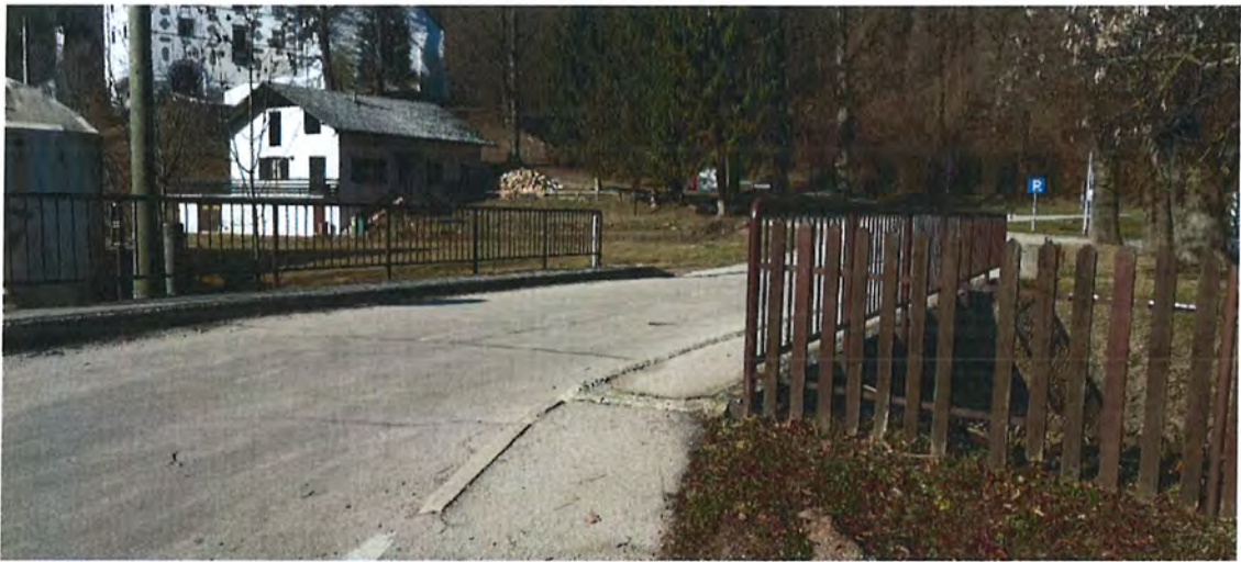
Slika 7: Obstoječi most na ulici Pot k ribniku
