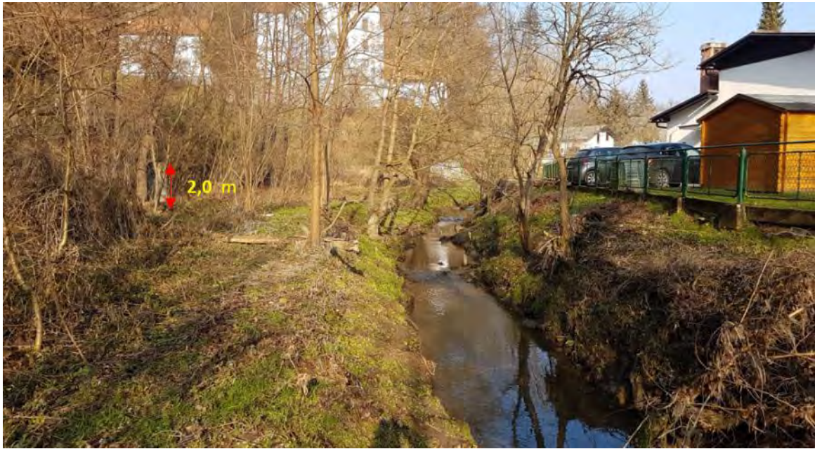
Slika 19: Pogled na traso in zelo visoke kanalizacijske jaške, ki segajo do 2,0 m višine. Levo od močvirnatega dela se relativno strmo dviguje brežina, ki je iz sljudnatih peščenjakov, na izravnavi smo zasledili manjše izvire, ki so posledica kontakta med bolj in manj prepustnimi kamninami.
