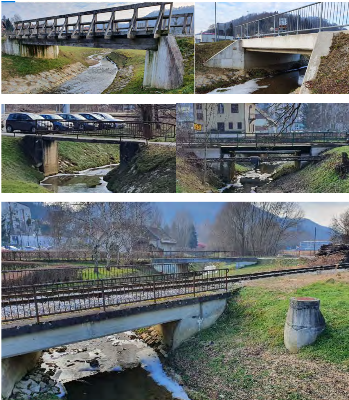
Slike 4a do 4e: Obstoječe premostitve dolvodno od Celjske ceste
