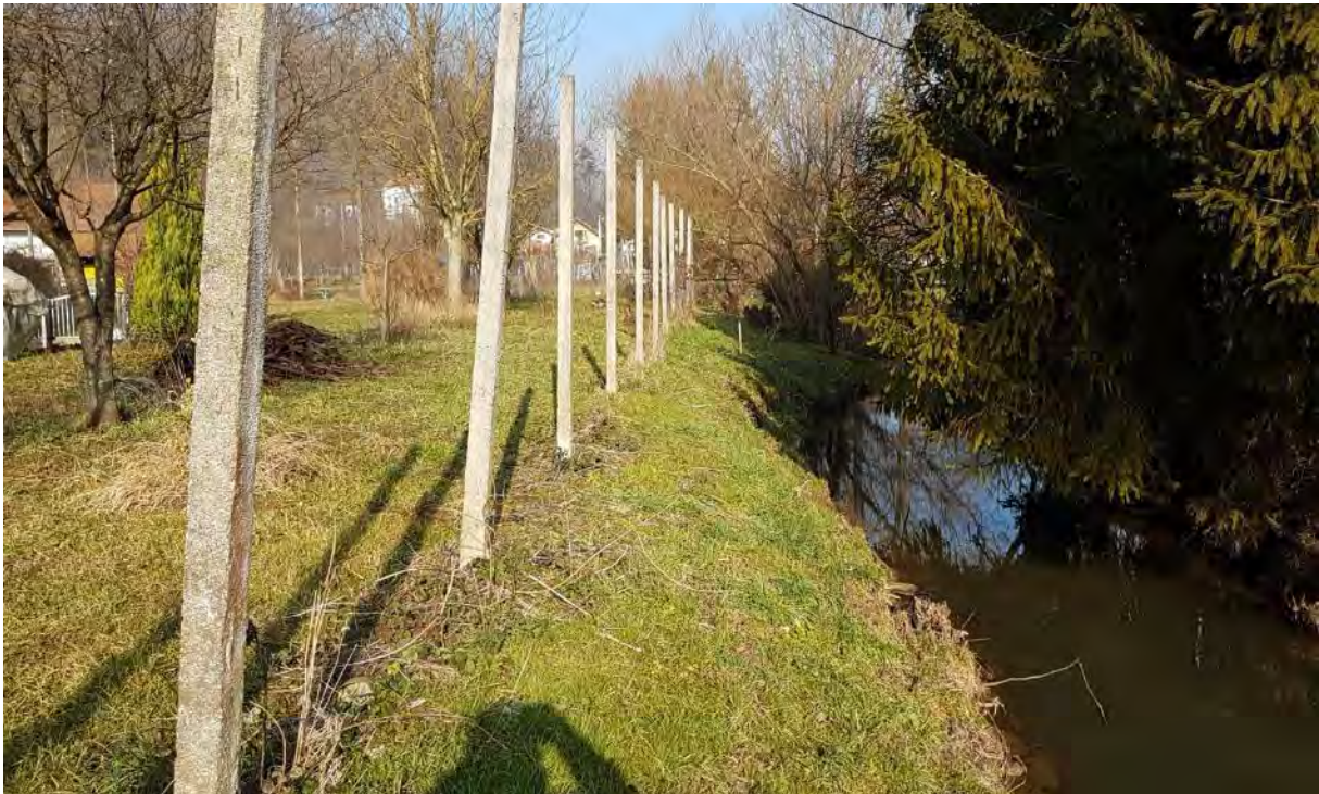
Slika 6: Nadaljevanje trase proti Dvorcu Strmol. Tukaj bo trasa še potekala po levi strani sedanjega potoka. Približno na tem mestu (na drugi strani potoka je transformatorska postaja) je predviden tudi novi most, pod katerim bo šel potok Draganja, ki se ga bo od približno te točke v smeri naraščanja stacionaž prestavilo levo, cesta pa bo šla približno po trasi sedanjega potoka.
