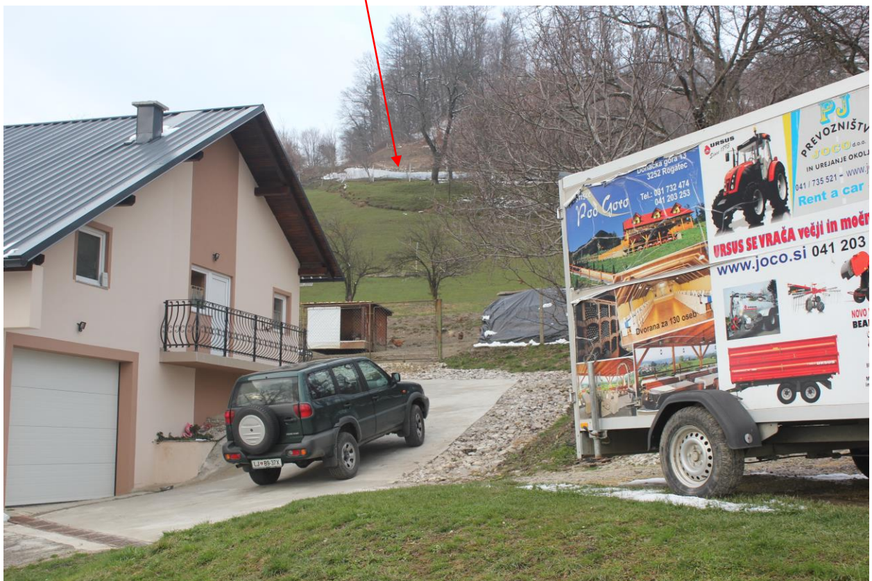
Pogled v zahodni del plazu in izrivni rob, kjer obstoja nevarnost zdrsa proti hiši.
