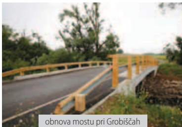
obnova mostu pri Grobiščah
