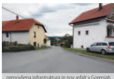
prenovljena infrastruktura in nov asfalt v Gorenjah
