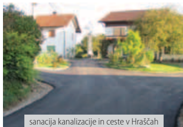
sanacija kanalizacije in ceste v Hraščah
