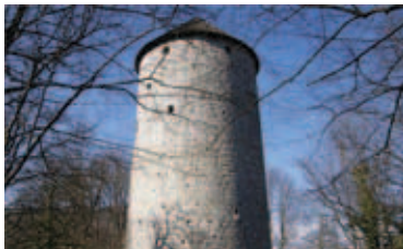
kmalu se bo pričela prenova Ravbarjevega stolpa
