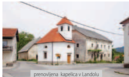
prenovljena kapelica v Landolu
