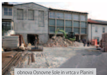
obnova Osnovne šole in vrtca v Planini
