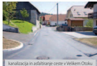
kanalizacija in asfaltiranje ceste v Velikem Otoku
