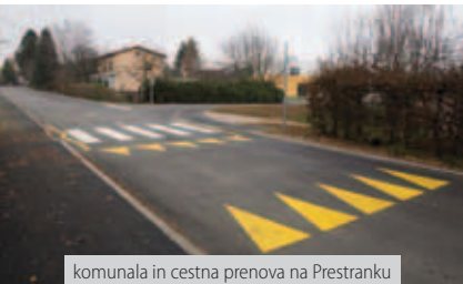
komunala in cestna prenova na Prestranku
