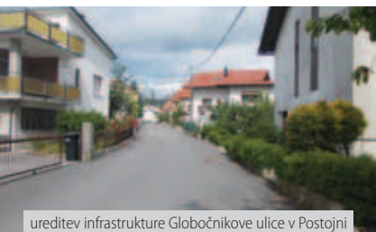
ureditev infrastrukture Globočnikove ulice v Postojni
