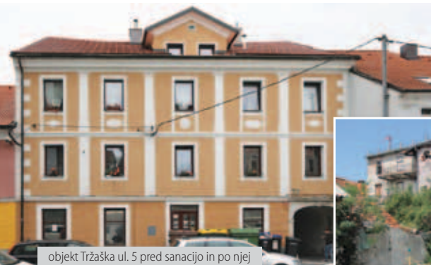
objekt Tržaška ul. 5 pred sanacijo in po njej
