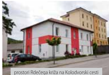
prostori Rdečega križa na Kolodvorski cesti
