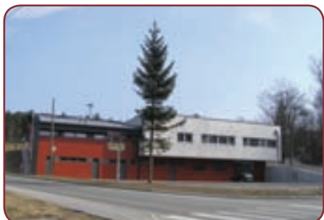
Kegljišče po izgradnji
