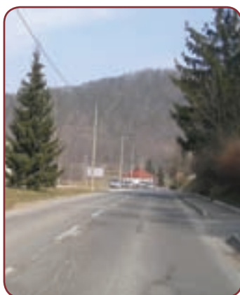
Kosovelova ulica pred začetkom obnove
