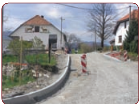
Dela v Bukovju potekajo
