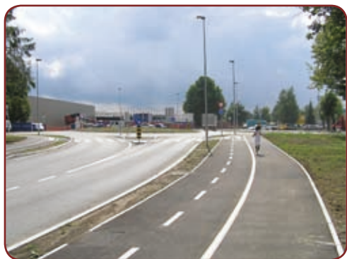
Dela na Kosovelovi vključno s krožiščem pri Mercatorju so zaključena, s krožiščem pri črpalki in s hortikulturno ureditvijo obeh krožišč se bodo nadaljevala spomladi
