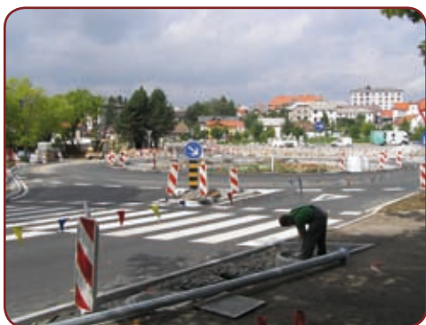
Zaključujejo se dela na krožišču pri Vrtnu
