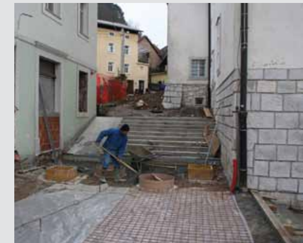
↑ Stopnišče v Majlont Zaključene so komunalne instalacije, ločen sistem kanalizacije in gradbena dela, v prihodnjih dneh pa bo stopnišče obloženo s kamnom.
