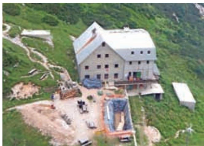
Izkopna jama na Kokrskem sedlu je namenjena dvema novima cisternama za vodo.
