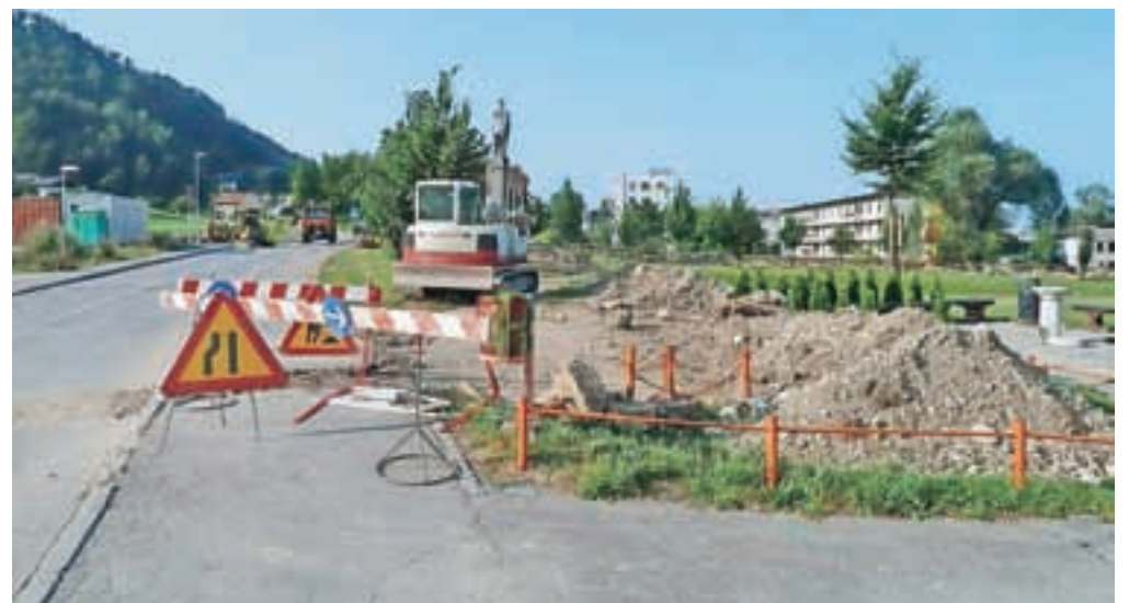
Toplovodne cevi so zamenjali tudi na Novem trgu.
