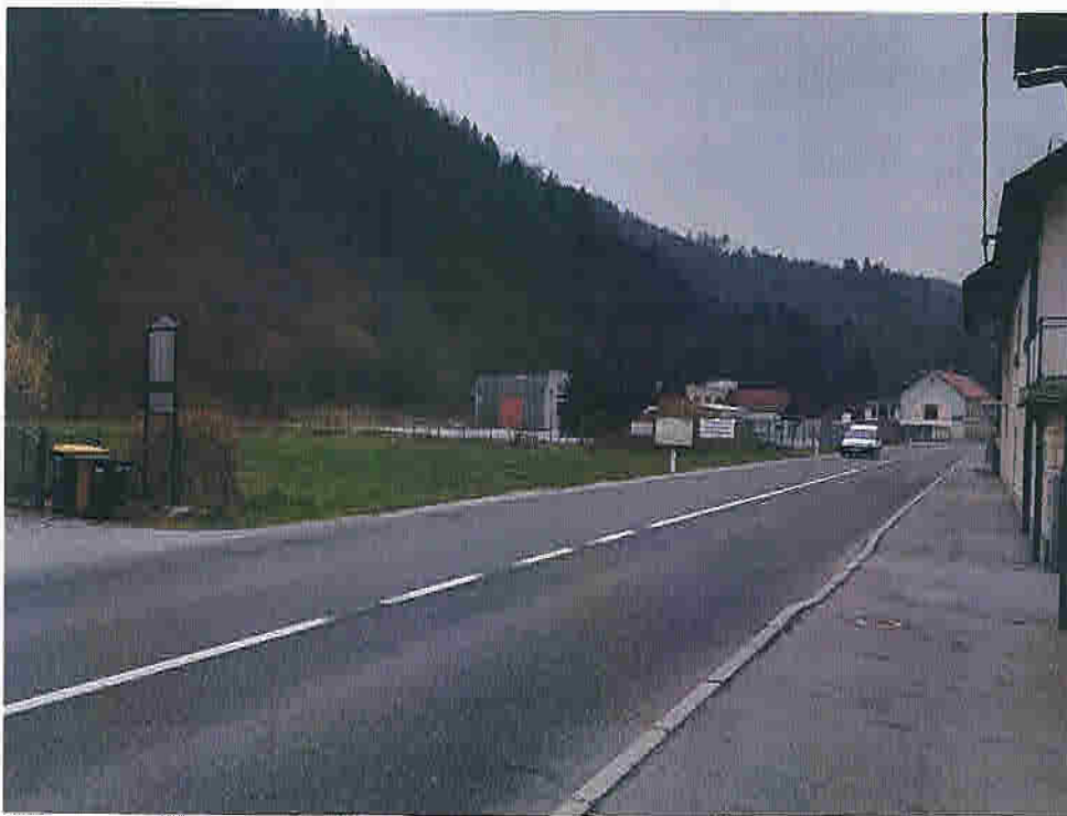
Slika 1: Pogled iz glavne ceste od SV proti JZ, slikano dne 20.11.2017
