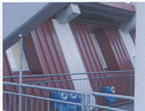
V vmesnem prostoru je bila pločevinasta obloga obnovljena, toplotne izgube so zmanjšane
