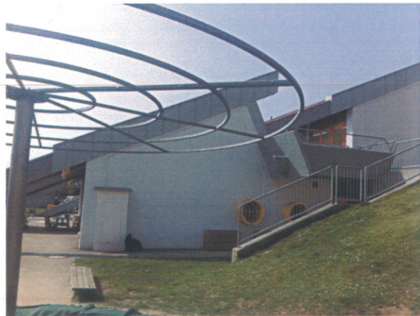
Pogled na severno fasado
