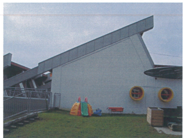
Vrtec Tinkara, delno izolirana fasada
