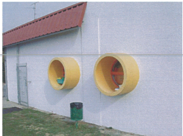
Vrtec Tinkara, toplotni mostovi
