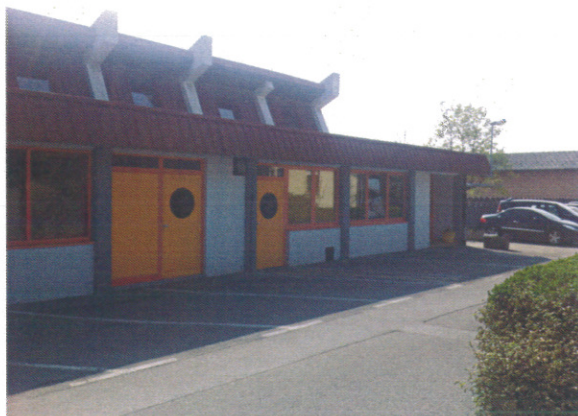
Pogled na objekt z zahodne strani, iz zgornjega nivoja
