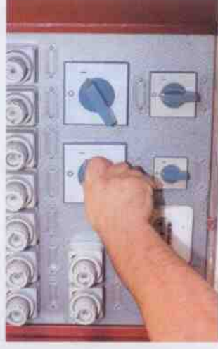
Slika 46: Izklap stikala/varovalke za elektriko (foto: Branko Petauer)
