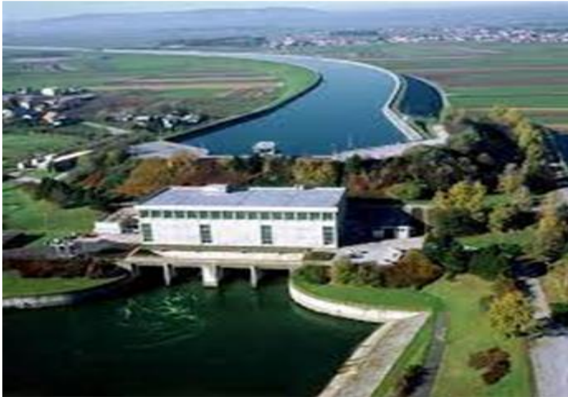
Hidroelektrarna Formin in dovodni kanal; foto: Arhiv DEM
