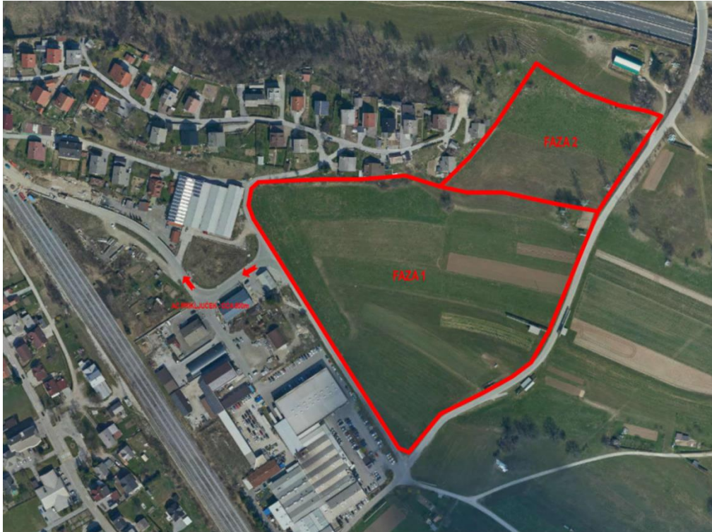
Slika št. 5: pogled na opsijsko lokacijo iz zraka. 16
