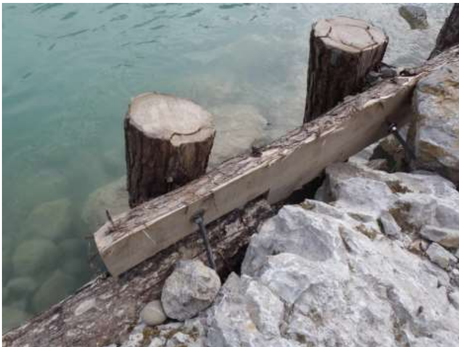
Slika 4: Tehnični detajl izdelave pilotne stene (vijačenje z vgreznjenimi stojnimi INOX palicam M16)
