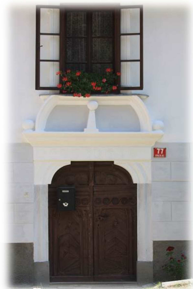
Slika 12: Dohtarjeva hiša Vir: Arhiv občine Bistrica ob Sotli
