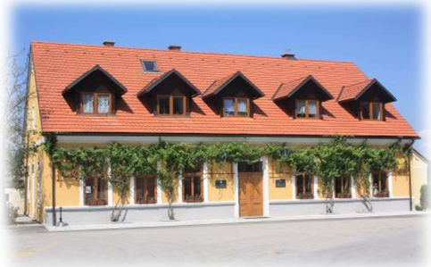
Slika 10: Občinska stavba Vir: Arhiv občine Bistrica ob Sotli
